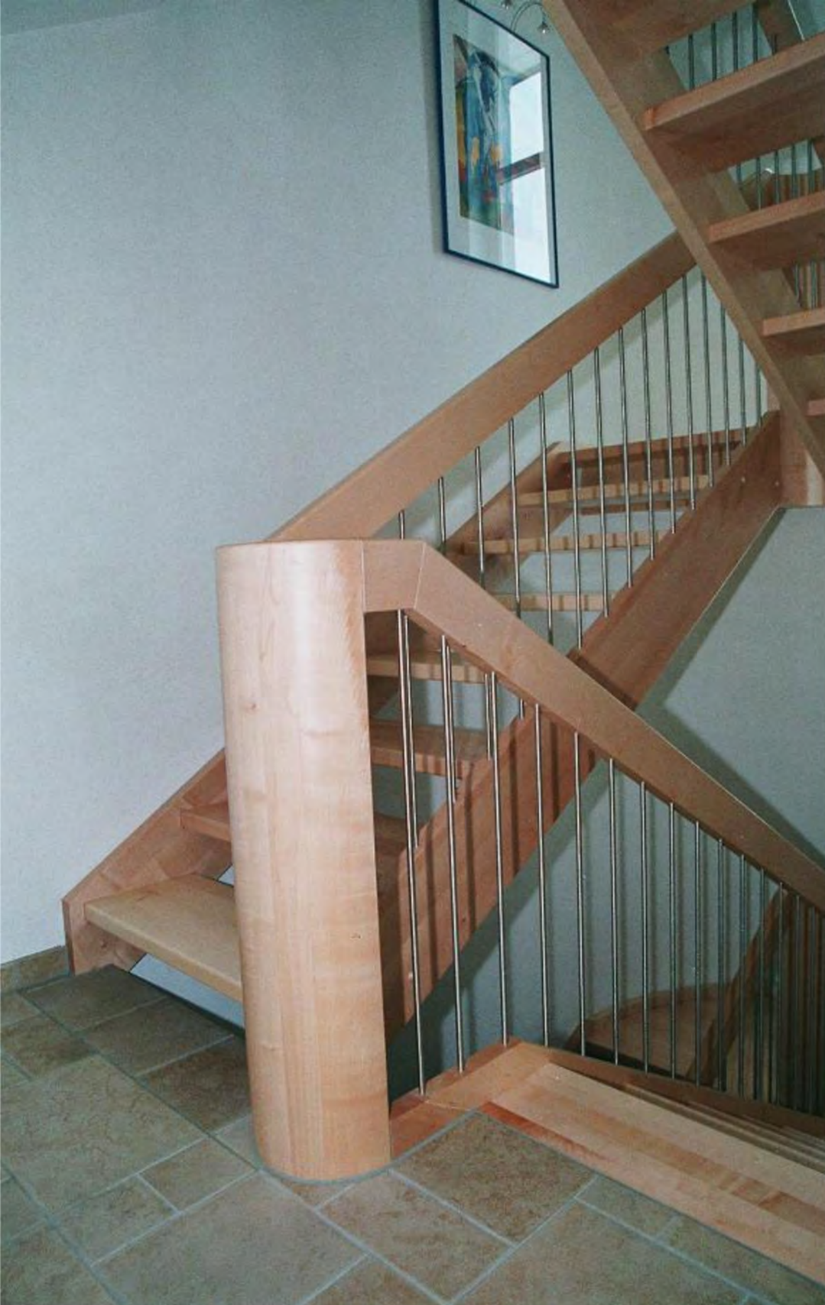
Treppe aus kanad. Ahorn Geländerfüllung: Edelstahl Rundstäbe
