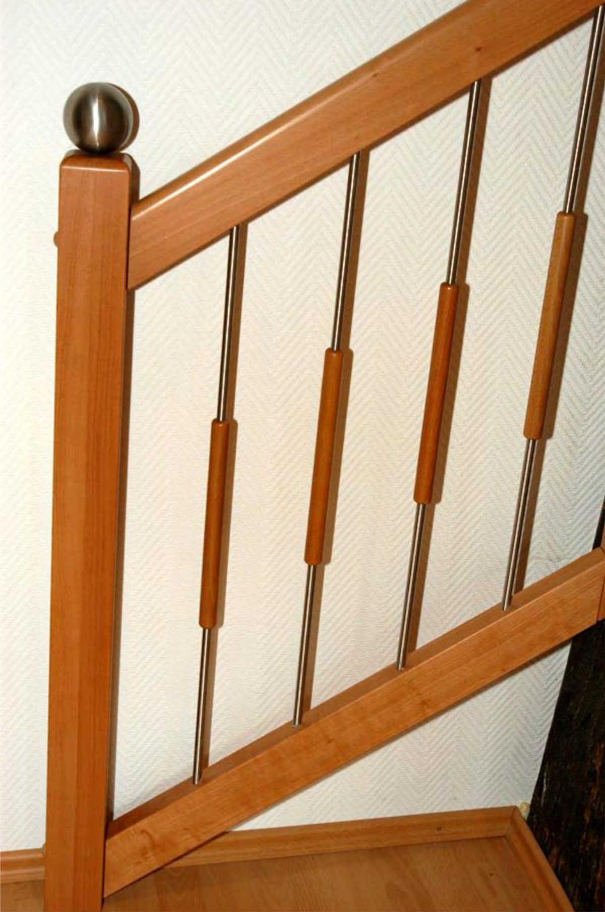
Buche/Edelstahl Geländer Edelstahlkugel - Aufsatz D = 80 mm
