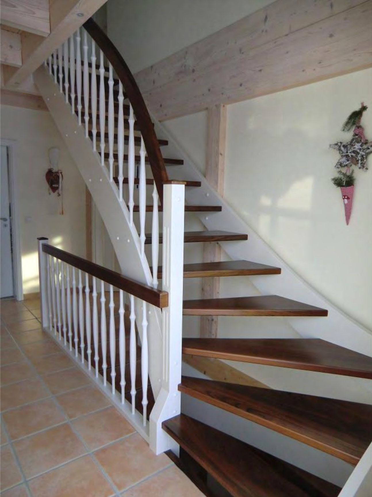
Wangentreppe weiß lackiert mit gedrehten Stäben Handlauf & Stufen aus Ovangkol lackiert
