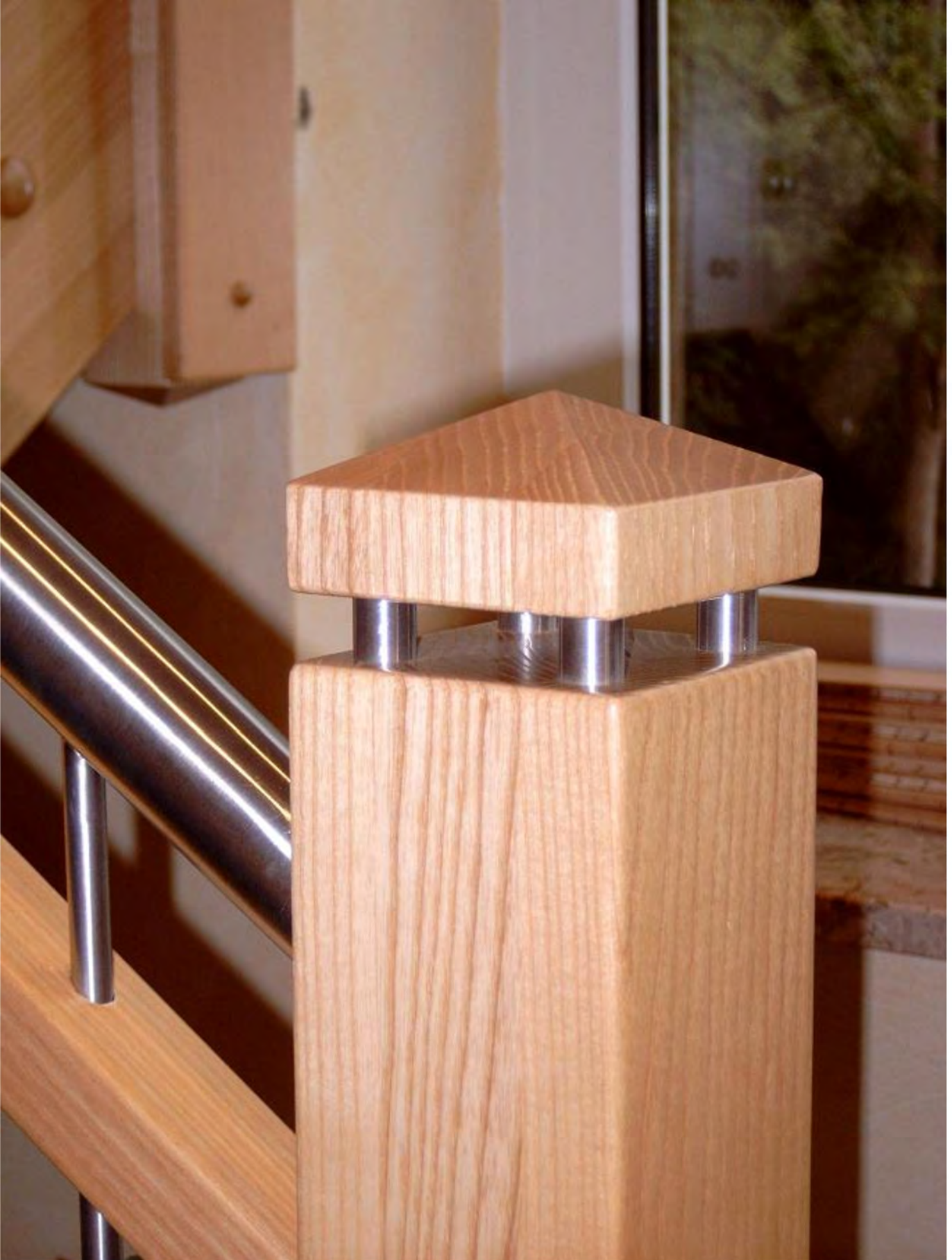
Pfostenaufsatz Holz verbunden durch Edelstahl - Abstandsstäbe
